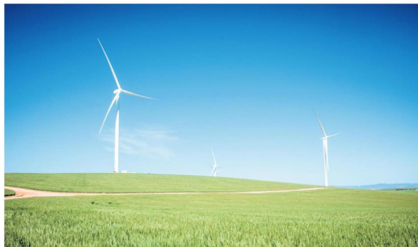
Die Excelsior-windplaas van 32,5 MW sowat 30 km suidwes van Swellendam in die Overberg wat deur BioTherm Energy ontwikkel is. Die windplaas het op 23 Desember verlede jaar kommersieel in bedryf gekom. Dit bestaan uit 13 windturbines met 'n vermoë van 2,5 MW elk.
